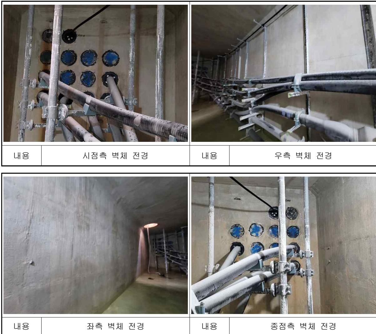
【사진 4.53】 남면~백석#12 전경
