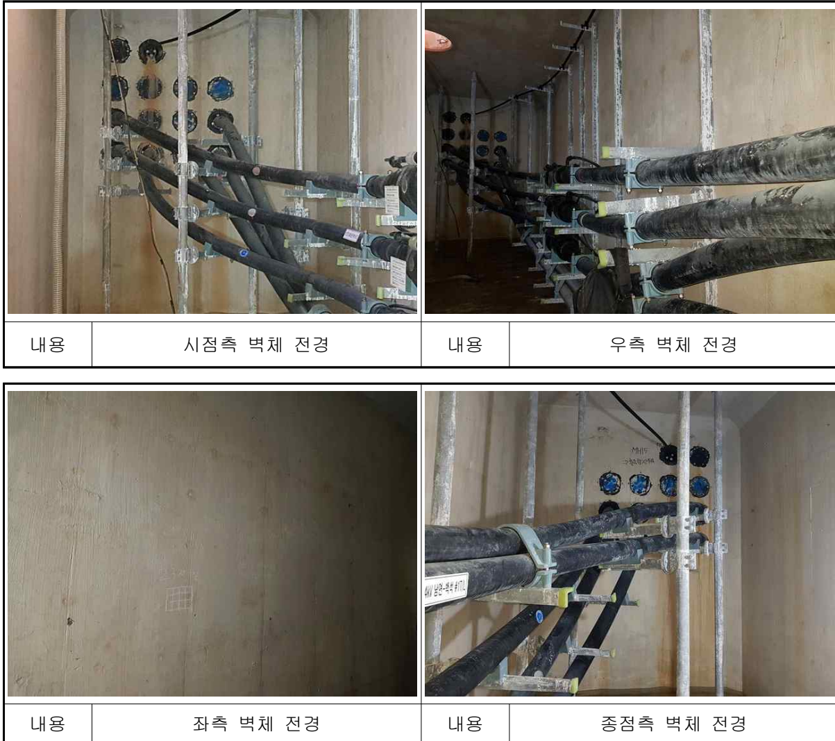
【사진 4.65】 남면~백석#15 전경
