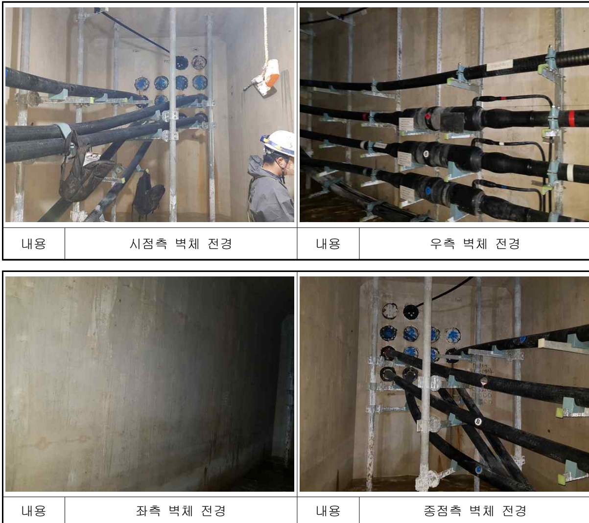
【사진 4.61】 남면~백석#14 전경
