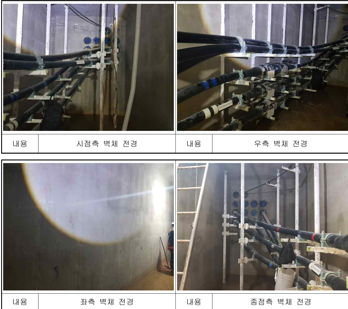
【사진 4.13】 남면~백석#2 전경
