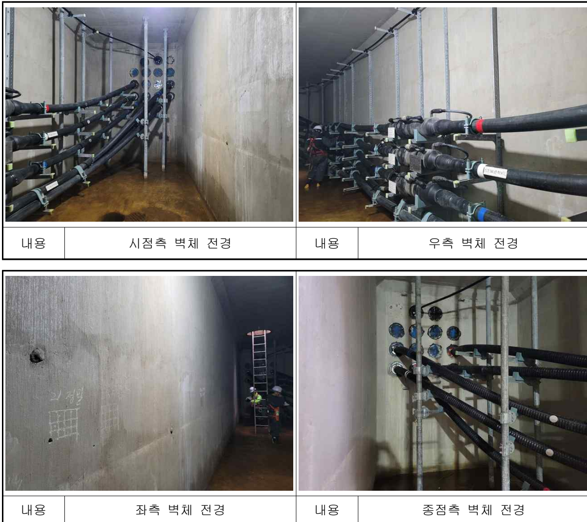
【사진 4.9】 남면~백석#1 전경
