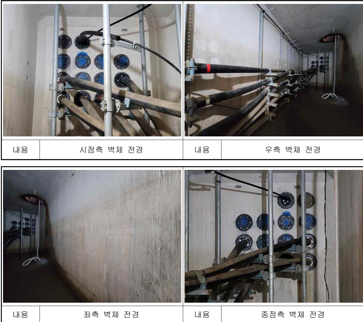
【사진 4.41】 남면~백석#9 전경
