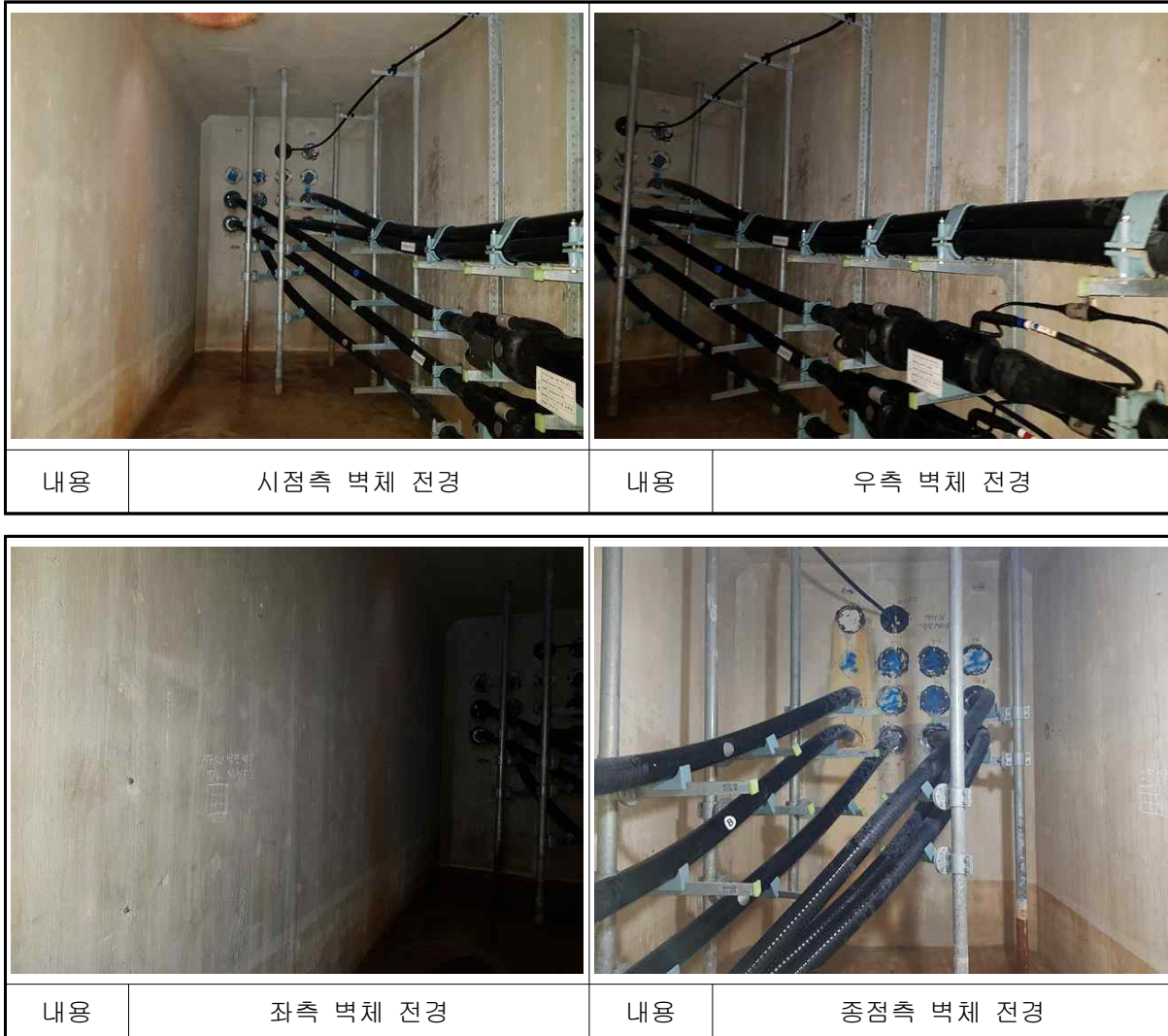
【사진 4.69】 남면~백석#16 전경
