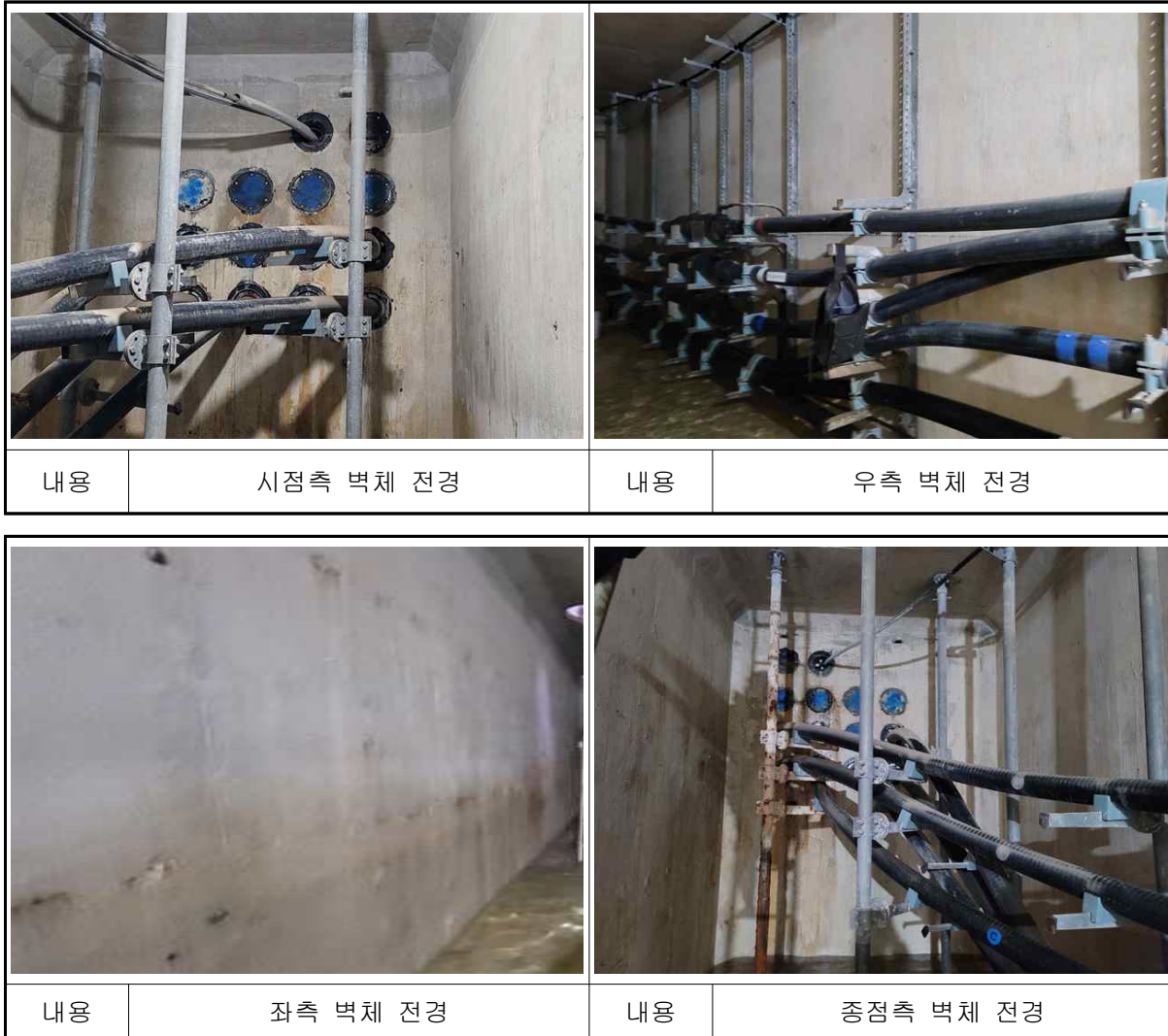
【사진 4.49】 남면~백석#11 전경
