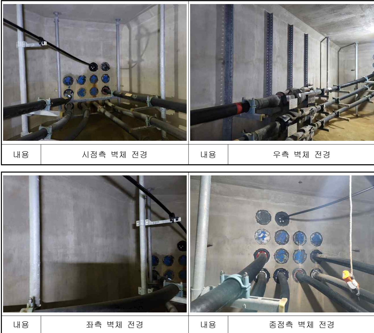
【사진 4.21】 남면~백석#4 전경
