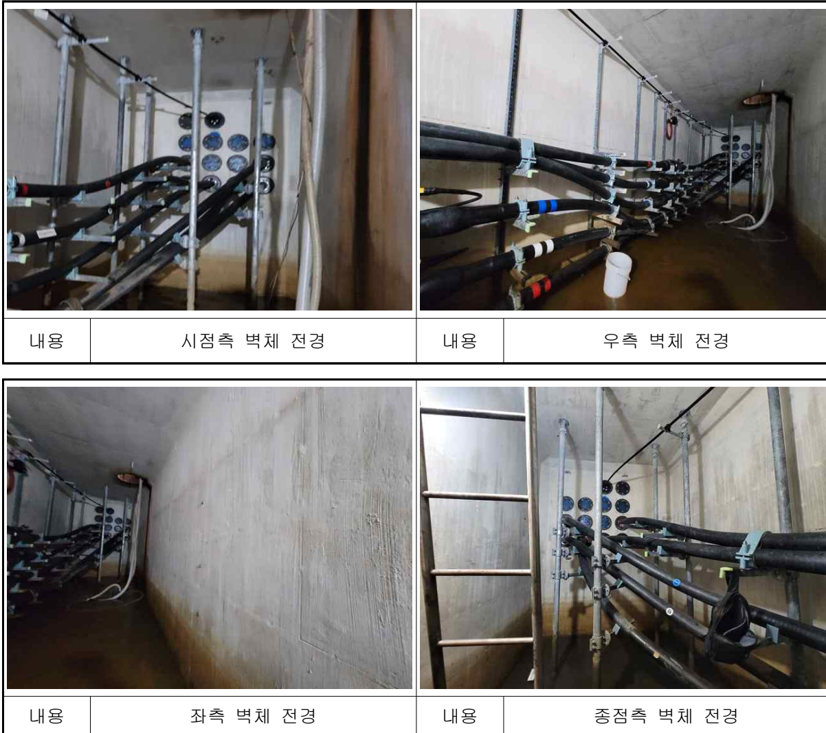
【사진 4.37】 남면~백석#8 전경
