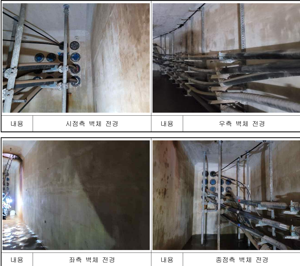
【사진 4.45】 남면~백석#10 전경
