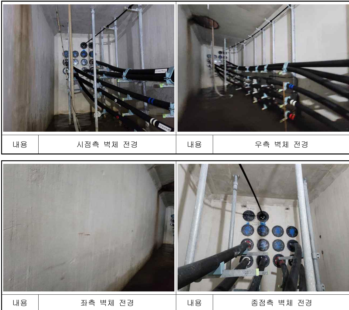
【사진 4.29】 남면~백석#6 전경
